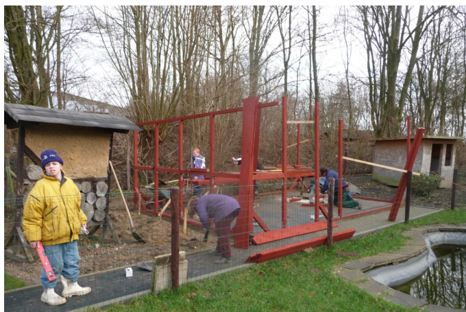
Aufbau des Ständergerüsts
