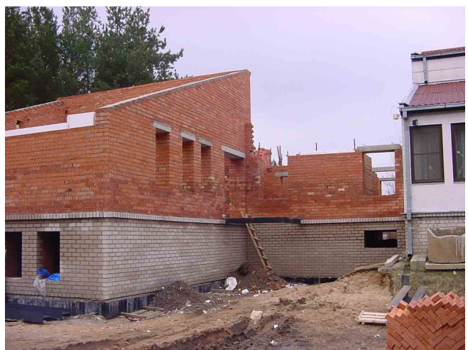
Stand der Bauarbeiten im März 2007
